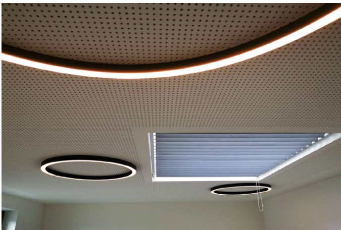
Beispiele innovativer Klimatisierung (Fotos links).
